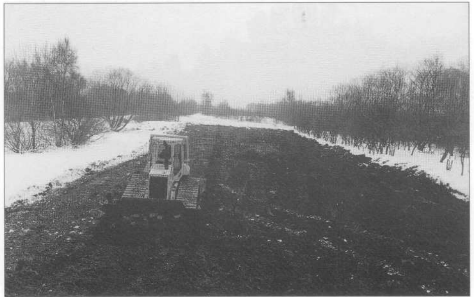
Abb. 3: Zur Neuentwicklung von Feuchtheiden wurde ein Pfeifengras-Dominanzbestand mitsamt des nährstoffreichen Oberbodens abgeschoben.
